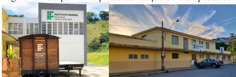
Imagens 2 : vista parcial do prédio da Estação Central após as obras.
