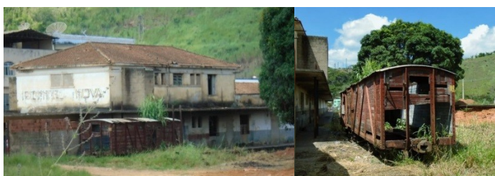
Imagem 1: vista parcial do prédio da Estação Central antes das obras.
