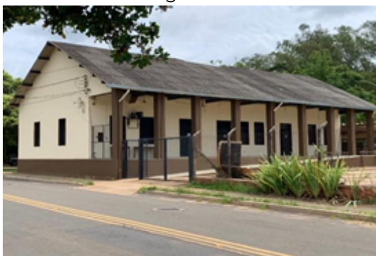
Figura 11: Galpão que abriga Salas de Aulas da Agronomia.
