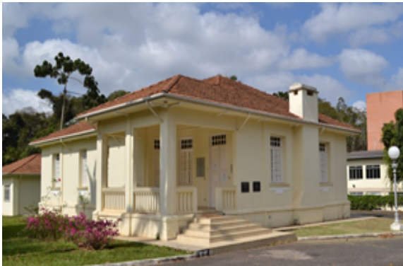
Figura 7: Casa de hóspedes (antiga residência do vice-diretor da ESAV).
