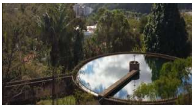
Figura 3 - Decantador da ETA- UFV.
