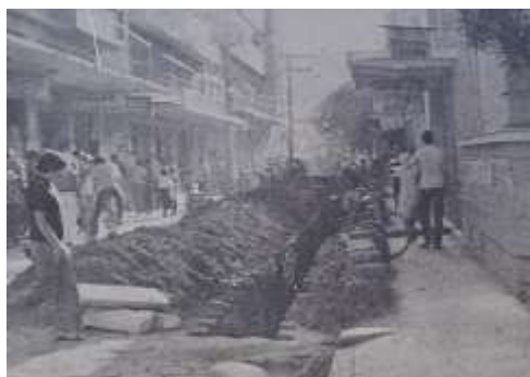
Figura 4 - Foto da reportagem “Obras da rua Arthur Bernardes marcarão Administração César Santana”
