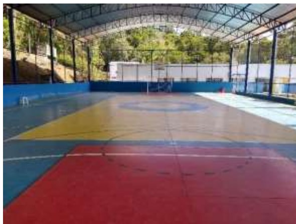
Figura 1 – Quadra de aula coberta da escola estadual 1.
