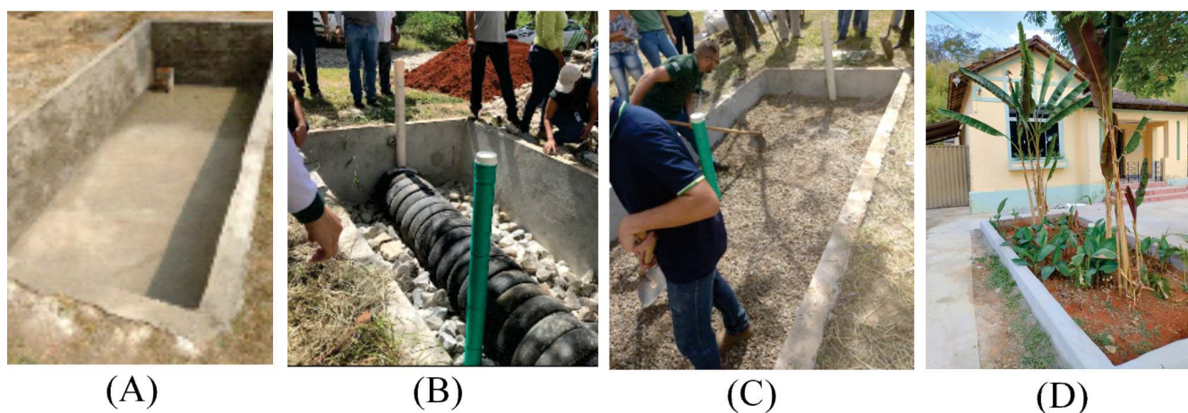
Figura 1 – A) Preenchimento da estrutura; B) Instalação da câmara anaeróbica; C) Fase de preenchimento da vala; D) Sistema concluído.
