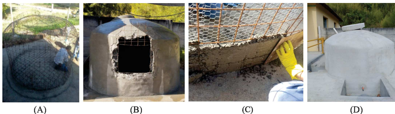
Figura 2 – A) Estrutura metálica da cisterna; B) Fixação de cimento; C) Cura da cisterna; D) Cisterna finalizada. Fonte: Elaborado pelos autores (2024).
