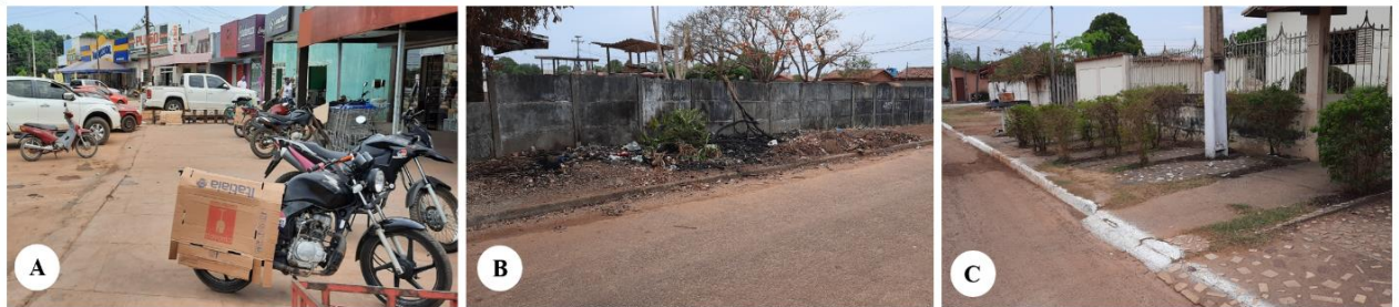
Figura 2 – Passeio público no núcleo urbano de Santana do Araguaia; (A) Motorizados estacionados no passeio público; (B) Passeio público sem pavimentação adequada e com entulho; (C) Mobiliários urbanos localizados no espaço destinado à circulação dos pedestres, sem demarcação da faixa de serviço.
