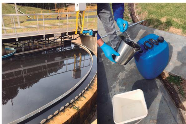
Figura 2 - Decantador secundário circular e coleta da água para reúso na hidroponia.
