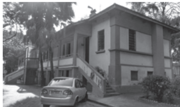
Figura 10 - Prédio Administrativo (2017). Fonte: pesquisadores, 2017.
