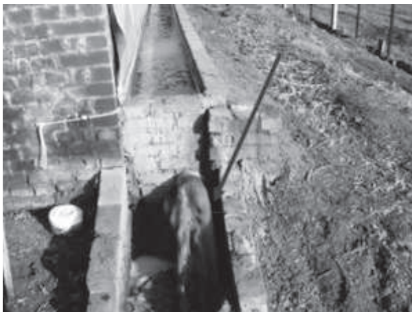
Figura 1 - Caneleta de coleta de dejetos suínos. Fonte: Autores.
